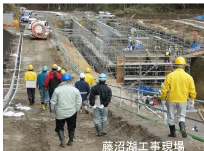
藤沼湖工事現場
